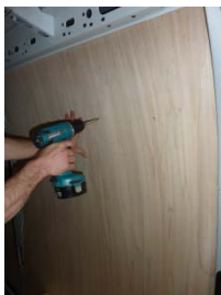
Placez et vissez les deux parties du Côté AR Droit 21 vis 4x30
