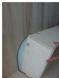
Placez & vissez le passage de roue Gauche 7 vis 4x30
