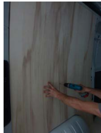
Placez & vissez les deux parties du Côté AR Gauche 21 vis 4x30
